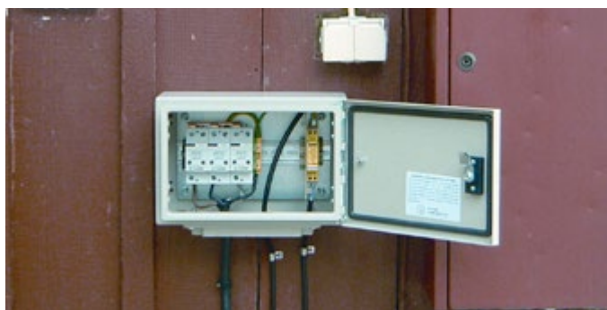
Exempel på inledningsskydd för el och tele.
