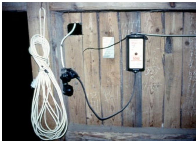
Elstängselapparat får inte placeras på en oskyddad trävägg.
